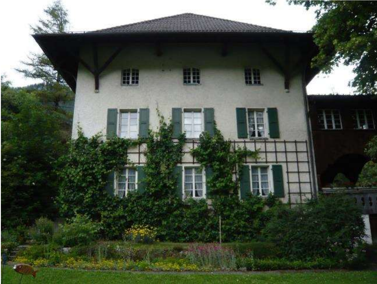
Pfarrhaus Zweisimmen vor der Sanierung, M. Trachsel
