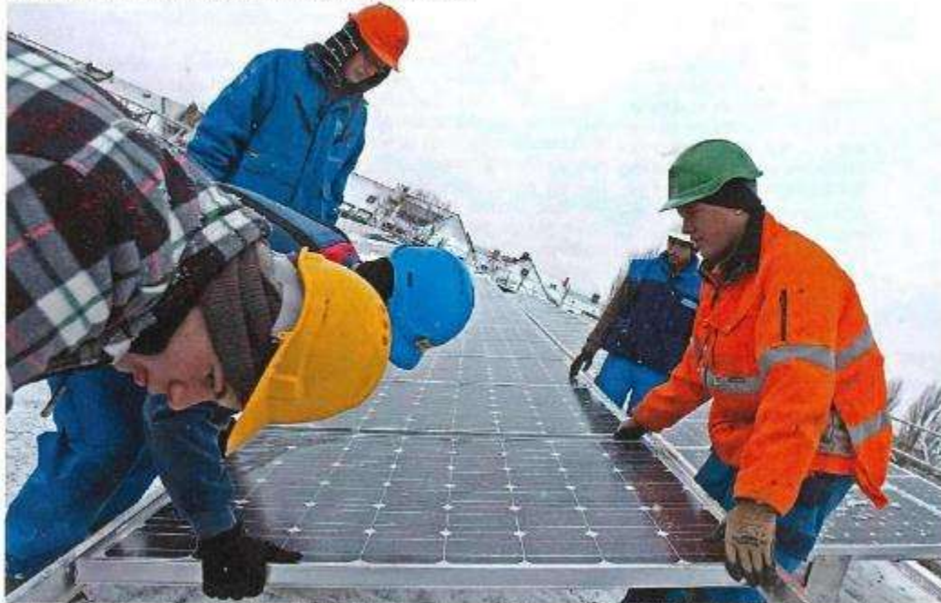
Noch werden in der Stadt Bern unterdurchschnittlich viele Solaranlagen auf Dächer montiert. Im Bild: Die Installation von Solarpanels auf der GIBB Berufsschule 2016. Foto: Beat Mathys
